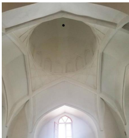
10-rasm. Maqbara ustidagi gumbaz osti konstruksiyasi.
